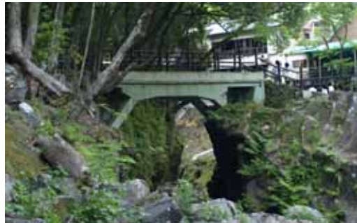
「どげんかして！」のRC方杖ラーメン橋
