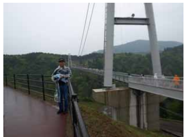
九重夢大吊橋
